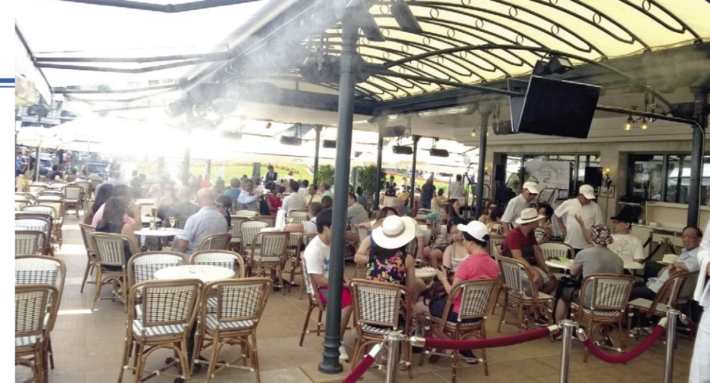
Kylsystem med högtrycksdysor i Cafe de Paris, Monte Carlo. Befuktningssystemet fungerar ljudlöst med tidsintervaller. Fem sekunder på och med fem sekunders paus, annars blir dimman för tät. Kyleffekten är enorm och stör ingen i restaurangen då persiennerna skyddar mot direkta solljus. Hovmästaren kan själv ställa in tidsintervallerna vid behov.
